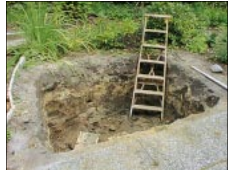
Bild 2: Den Ausgangspunkt bildet das Ausschachten der Grube – 4 m 3 Erdrich!
