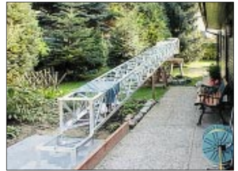
Bild 7: Zum Aufrichten des 120 kg schweren Mastes bedarf es unbedingt mehrerer Helfer.
