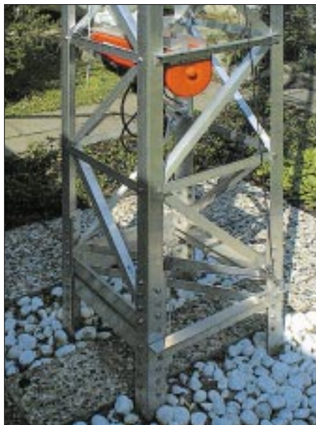
Bild 8: Mastfuß mit Motorwinde; durch Abdecken mit Platten und Steinen fängt sich das Fundament gut in den Garten ein.
