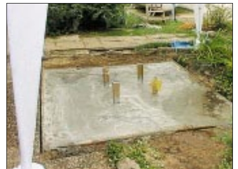
Bild 5: Das fertig gegossene Fundament ist einige Tage feuchtzuhalten und vor praller Sonne zu schützen – hier mittels Partyzelt.
