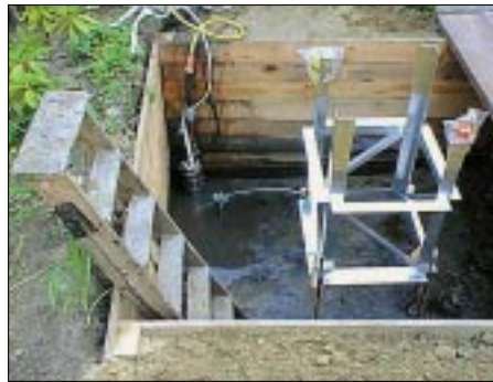
Bild 4: Der ausgerichtete und verankerte Mastfuß
