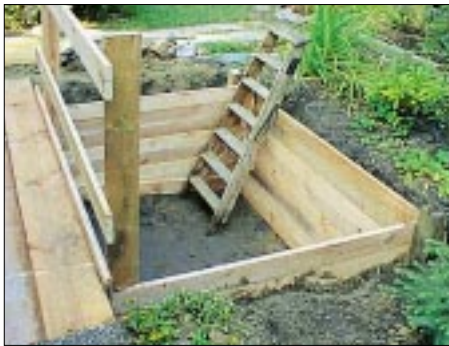
Bild 3: Schalbretter verhindern das Einstürzen der Grubenwände.
