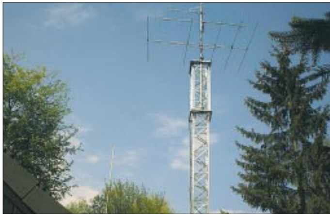
Bild 1: Bis Mast und Antennen den Garten zieren, ist es noch ein weiter Weg ...
