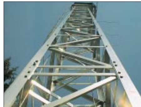
Bild 9: Am Ziel – der zusammengeschräubte Gittermast ist aufgerichtet. Fotos: DC7KM
