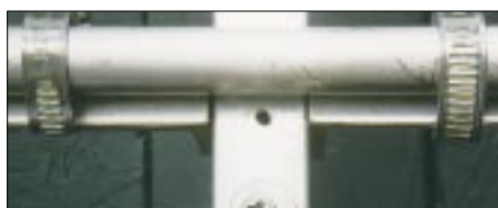
Bild 2: Schlauchschellen als Elementhalter, Ansicht von oben
